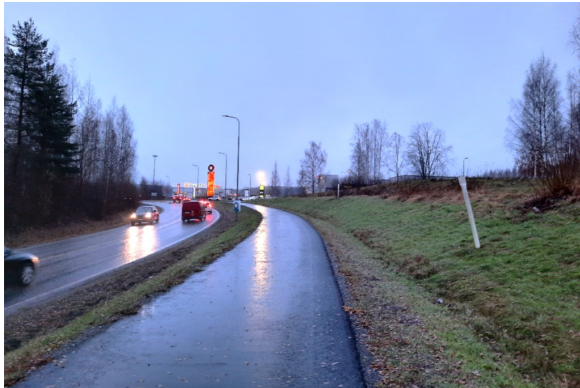
Kuva 3. Näkymä asemakaava-alueen pohjoisrajalta kohti etelää. Väylien reunoilla on hulevesipainanteet ja länsirajalla kulkee lisäksi Tampereen kaupungin kaasuputkilinja. ©Tampereen kaupunki 2023.
