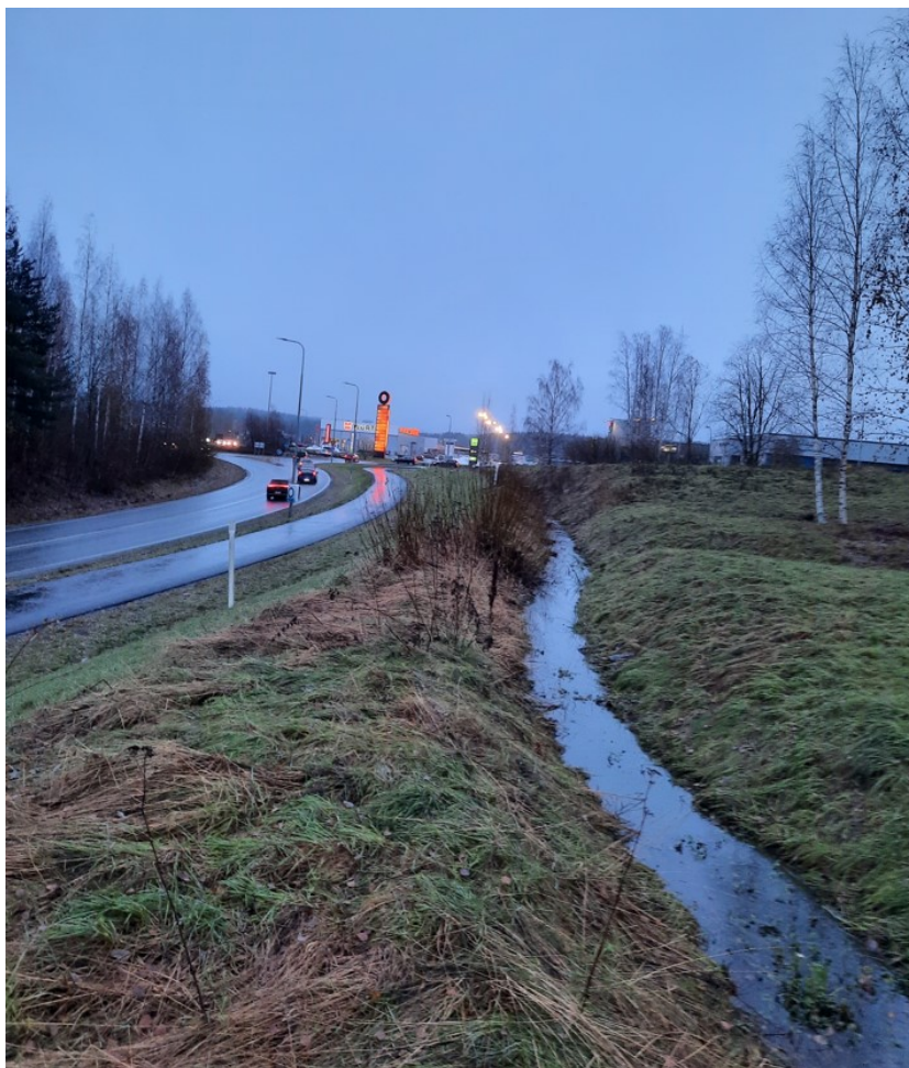
Kuva 4. Väylän länsipenkereen päällä avo-ojan hulevesi laskee etelään kohti Toivionkatua. Kuva on otettu Tampereen ja Pirkkalan rajalta kohti etelää. © Tampereen kaupunki 2023.
